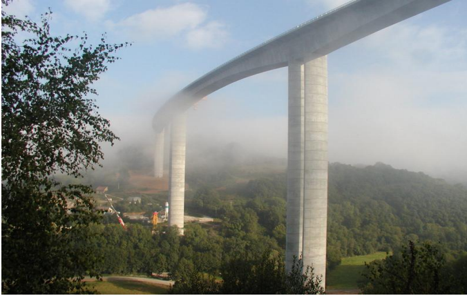
Fig. (1-2) Silica Fume used in Viaduc de Tulle Bridge, France.
